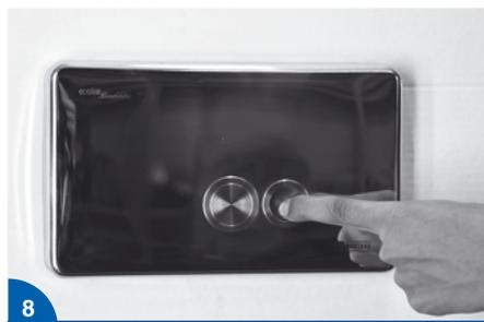
FAÇA UMA PRÉ-MONTAGEM DO ESPELHO METÁLICO E ACIONE OS BOTÕES. AO ACIONAR OS BOTÕES, ELAS DEVEM ENTRAR DE 3 A 4 mm ANTES DE EFETIVAMENTE ACIONAREM DESCARGA. PARA REGULAR ESTA "FOLGA", PROCEDA COM A OPERAÇÃO DO ITEM 7, APERTANDO OU AFROUXANDO OS PARAFUSOS DE ACIONAMENTO.
