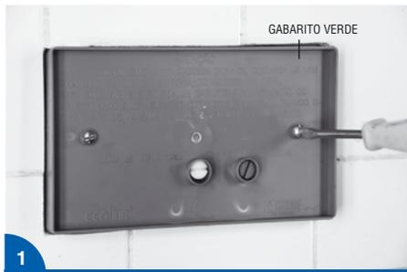
USANDO UMA CHAVE DE FENDA, RETIRE O GABARITO VERDE. NOTA: O GABARITO SÓ PODERÁ SER RETIRADO APÓS A COLOCAÇÃO DOS AZULEJOS.
