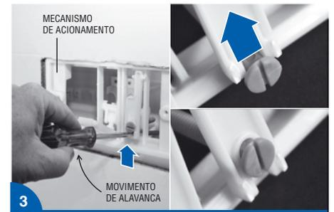
OS PARAFUSOS DEVEM SER ENCAIXADOS FIRMEMENTE NAS HASTES ATÉ O FIM DO LOCAL INDICADO, OU SEJA, LOGO ATRÁS DA CABEÇA DOS PARAFUSOS DE ACIONAMENTO. PARA TANTO, UTILIZE A CHAVE DE FENDA COMO ALAVANCA PARA FACILITAR O PROCESSO.
