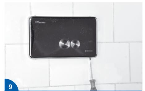
APÓS A REGULAGEM DOS BOTÕES, VERIFIQUE SE NÃO HÁ VAZAMENTO, E SE AS DESCARGAS FUNCIONAM NORMALMENTE. EM SEGUIDA, MONTE O ESPELHO SOBRE TAMPA EXTERNA, FIXANDO A MESMA COM OS QUATRO PARAFUSOS METÁLICOS FORNECIDOS. TESTE A CAIXA ACIONANDO O BOTÃO DE 3 LITROS, AGUARDE O ENCHIMENTO, E ACIONE O BOTÃO DE 6 LITROS.
