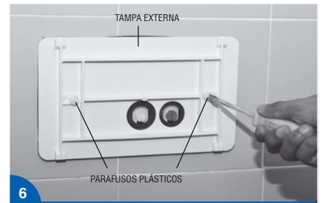
UTILIZANDO OS DOIS PARAFUSOS PLÁSTICOS, FIXE A TAMPA EXTERNA NO MECANISMO DE ACIONAMENTO, SOBREPONDO OS AZULEJOS COMO MOSTRA A FOTO ACIMA, SEM APERTAR DEMAIS OS PARAFUSOS, PARA NÃO OCASIONAR O ACIONAMENTO DA DESCARGA.
