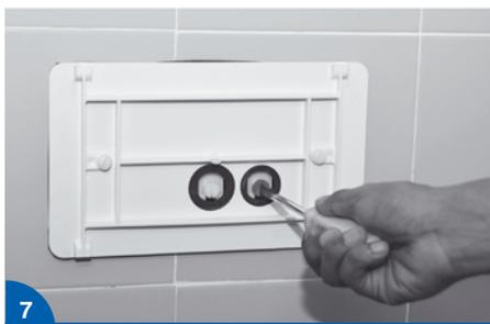
APERTE OS PARAFUSOS DE ACIONAMENTO VERDE E O BRANCO, ATÉ QUE SUAS CABEÇAS ESTEJAM FACEANDO COM A SUPERFÍCIE INTERNA DA TAMPA EXTERNA.
